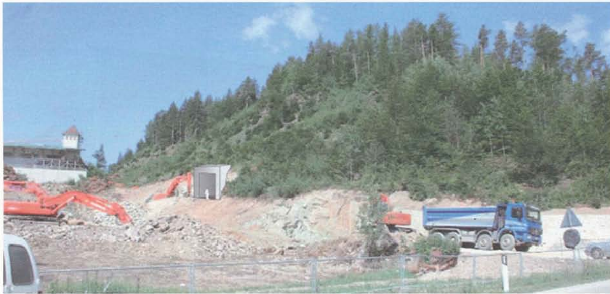
Versenktes Projekt Pumpspeicherwerk (geplanter Stolleneingang in Klobenstein, Montage): „Kelag“ und „WEB Windenergie AG“ ziehen sich zurück.
